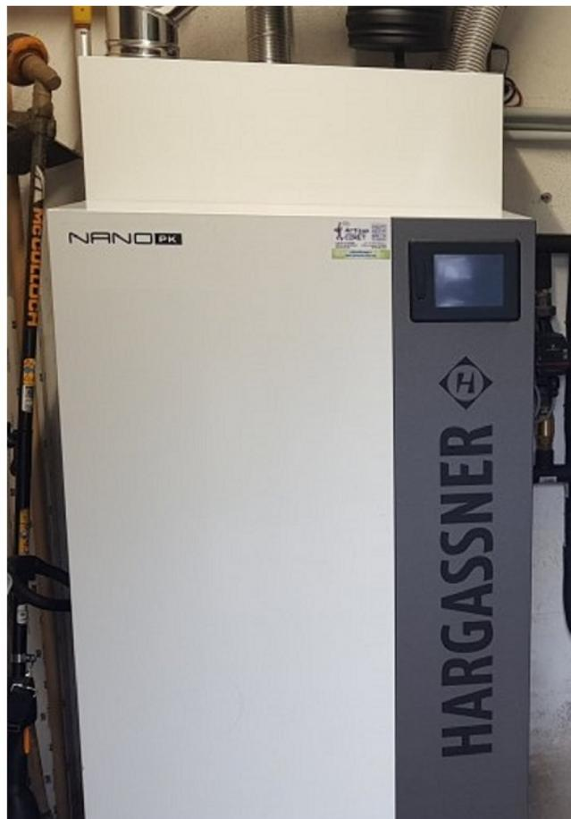
*Changement de la chaudière fioul par une chaudière aux granulés de bois HARGASSNER type NANO PK ventouse ! il faut environ 2 tonnes de granulés pour 1000 Litres de fioul, ce qui fait environ la moitié du coût du fioul. Chaudière Située à Ury*
