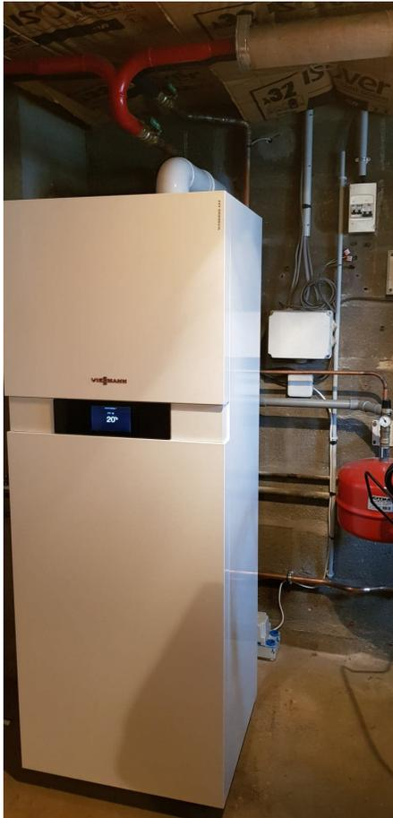
*Changement de la vieille chaudière Fioul De Dietrich par une chaudière gaz Condensation Haute performance énergétique de marque VIESSMANN type Vitodens 222 F . Préparateur d'eau chaude sanitaire spécifique eau Dure*
